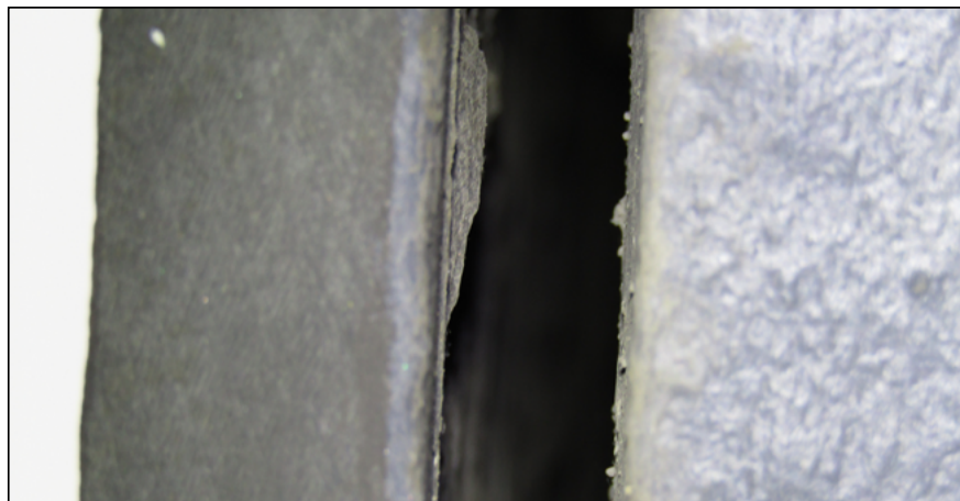
Figuur: de onderzijde van de gevel uit de figuur links.
