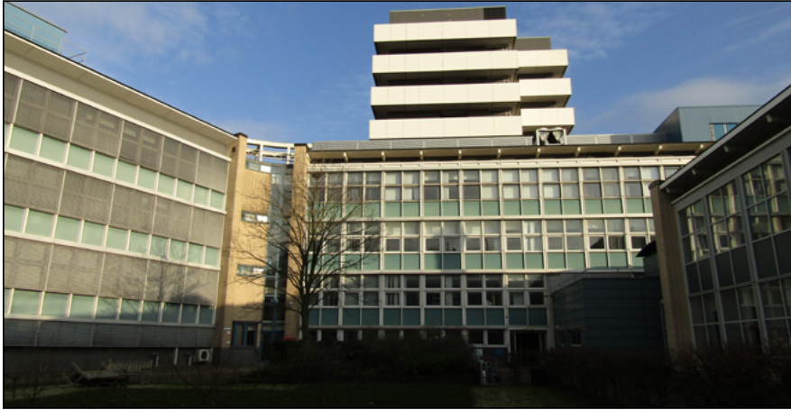
Figuur: het noordelijke gedeelte van het "U-gebouw", kijkrichting: oost. Dit gebouw wordt gesloopt.
