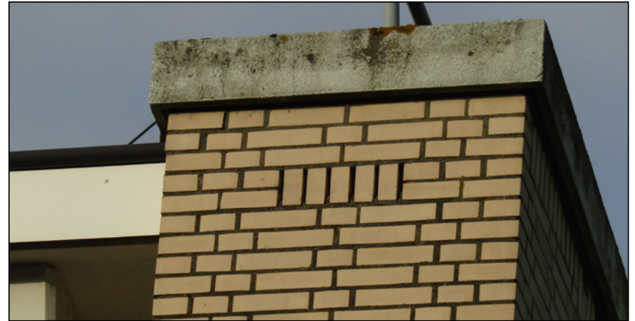
Figuur: de open stootvoegen bieden geschikte invliegopeningen voor vleermuizen, die verblijfplaatsen in de luchtspouw kunnen hebben.
