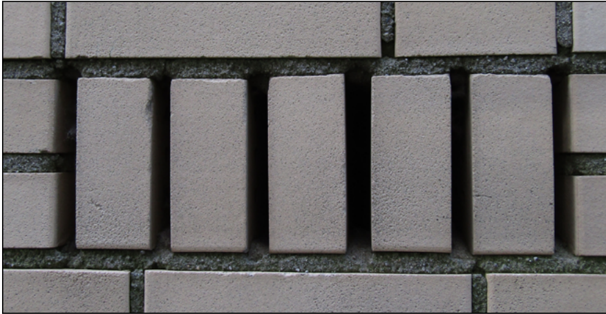
Figuur: de open stootvoegen maken de achterliggende luchtspouw toegankelijk voor zowel dwergvleermuizen, als voor grotere soorten (zoals laatvlieger en meervleermuis).
