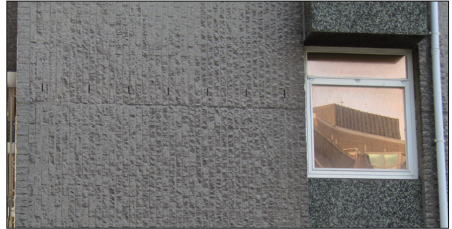
Figuur: de open stootvoegen maken de achterliggende luchtspouw toegankelijk voor vleermuizen.
