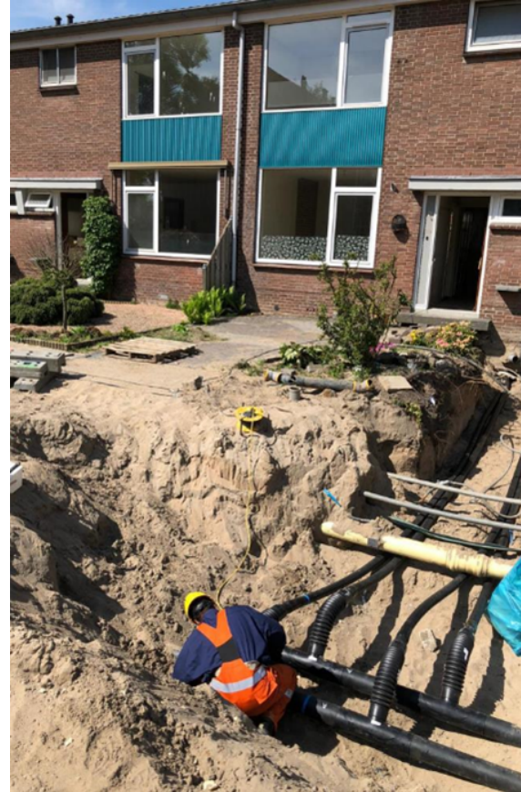
Leidingen in de straat
