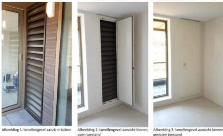
Figuur 2: Principe geluidwerend louvre (Comfortbox) aan de binnenzijde afsluitbaar
